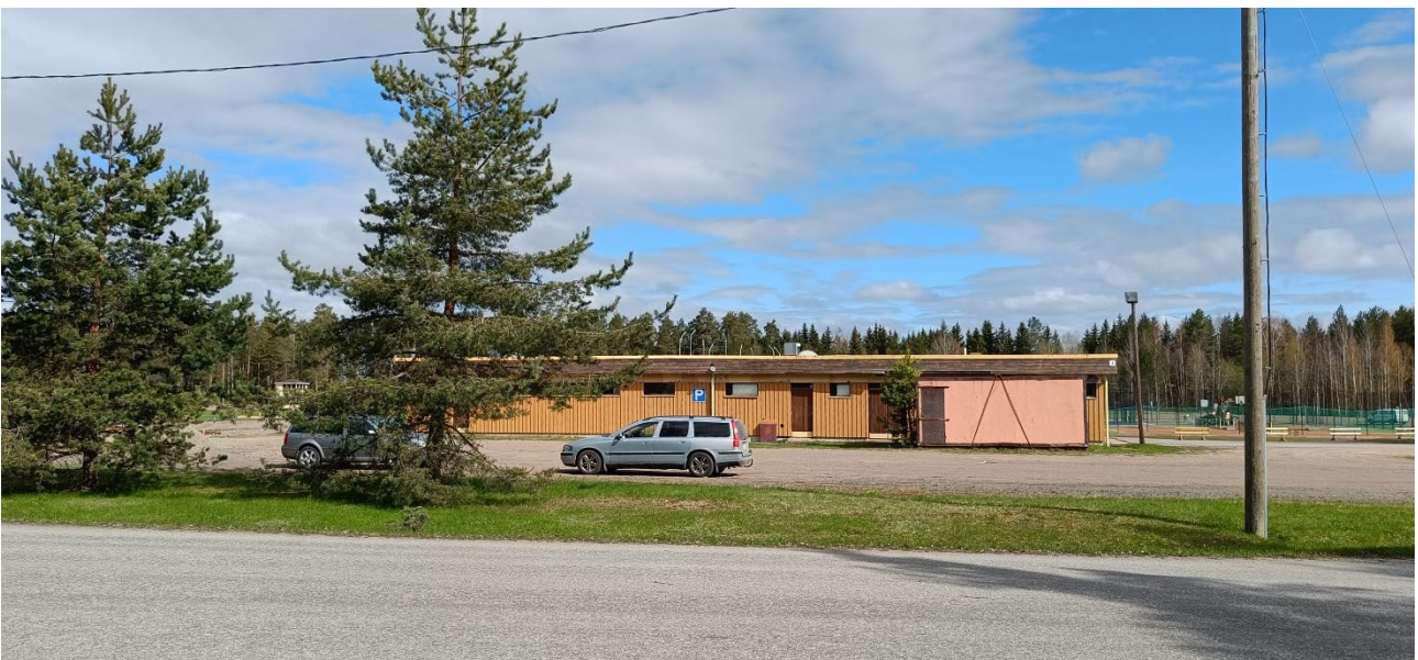
Kuva 9 Raviradan reunalla oleva pukukoppirakennus 1970-luvulta.
