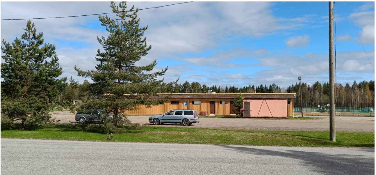
Kuva 9 Raviradan reunalla oleva pukukoppirakennus 1970-luvulta.
